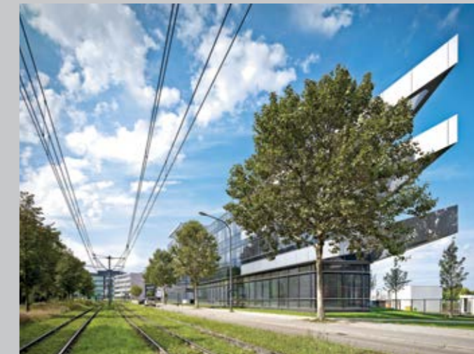
Abb.39: Gebäude der Firma Octapharma im Neuenheimer Feld
