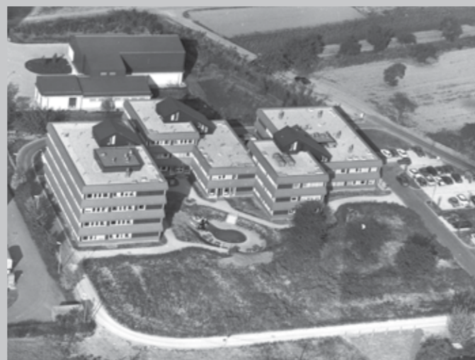
Abb.15: Fertiggestellter erster Bauabschnitt INF 517-519
