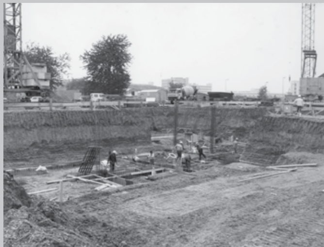
Abb.11: Erster Bauabschnitt: Baufortschritt September 1984
