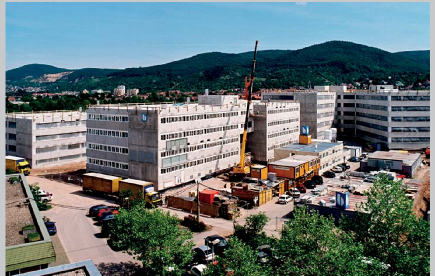
Abb.30: Baustelle des dritten Bauabschnitts im Neuenheimer Feld
