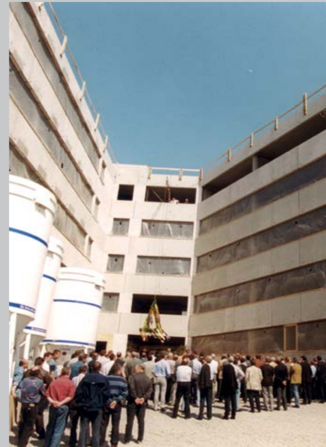
Abb.28: Richtfest des dritten Bauabschnitts am 2. Mai 2001
