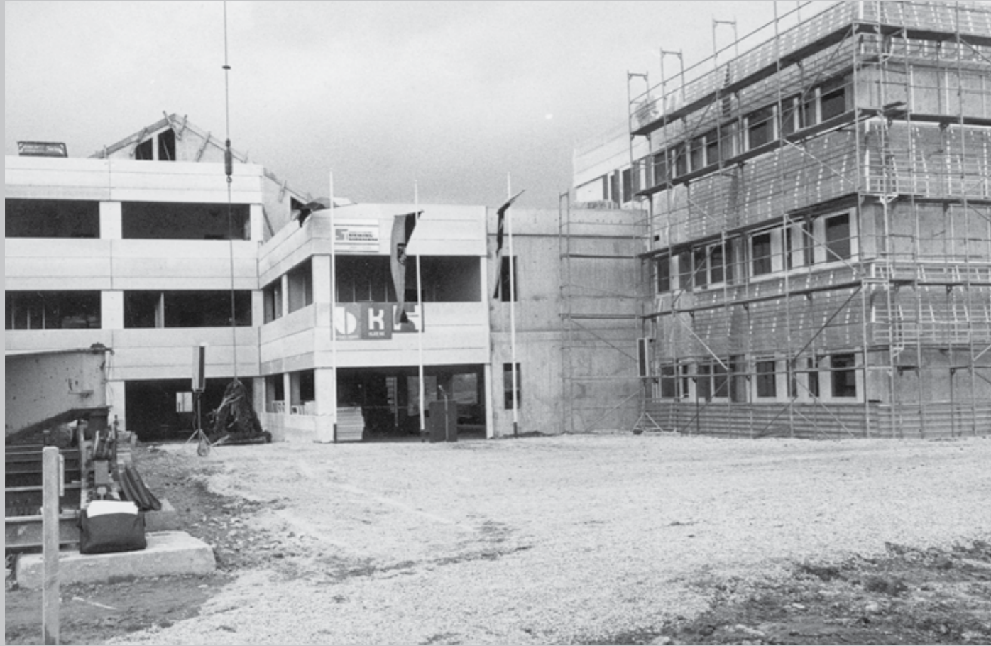
Abb.7: Richtfest des ersten Bauabschnitts am 15. März 1985: der Rohbau
