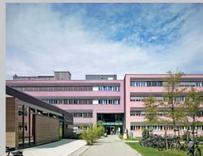
Abb.32: Das im dritten Bauabschnitt entstandene Gebäude 582
