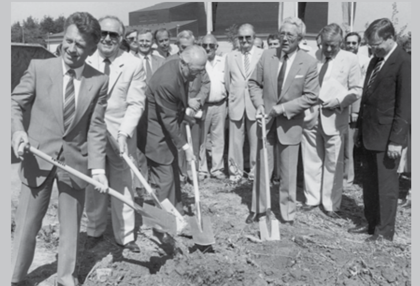
Abb.4: Offizieller Spatenstich für den ersten Bauabschnitt am 3. August 1984
